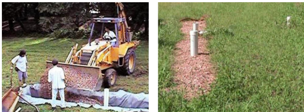
Figura 3-22 - Enchimento da trincheira com brita e monitoramento após sua construção ( SOUZA, 2002 ).
