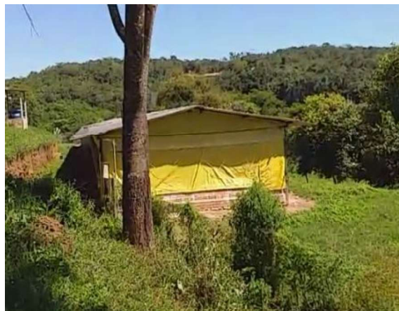
FIGURA 4 - Características do galpão 1
