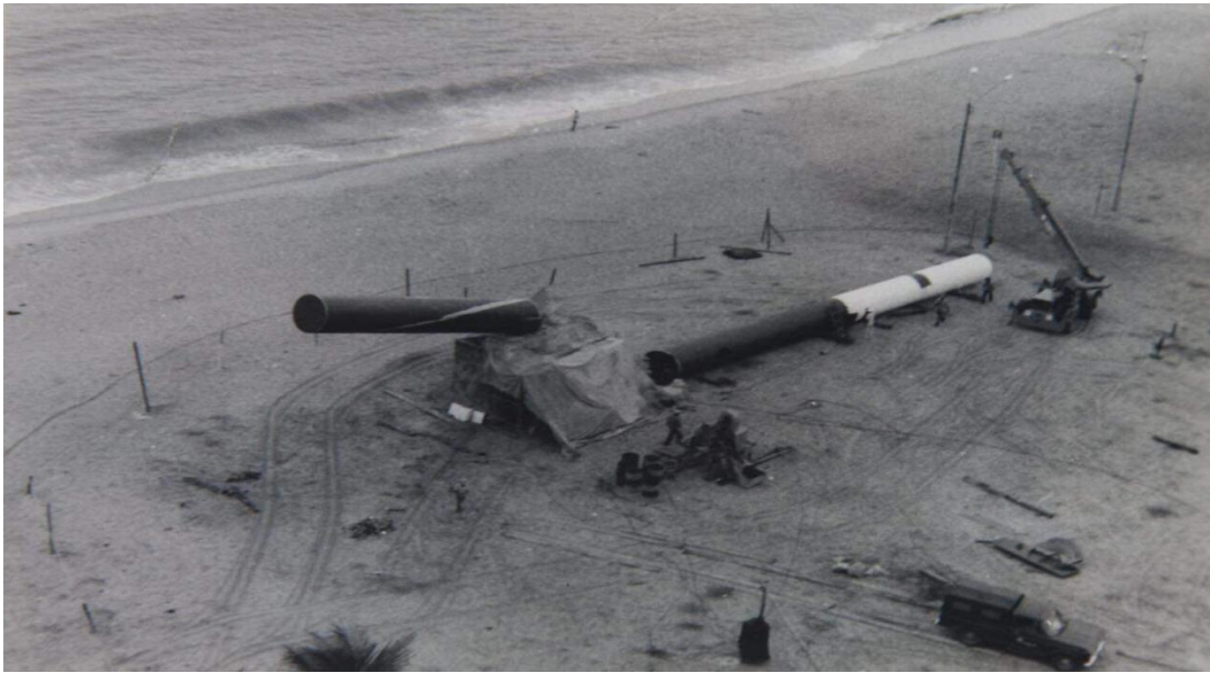
Figura 18: Canteiro de obras da construção da escultura, originalmente, cercada de areia e mar. Foto do acervo do Instituto de Arte Contemporânea
