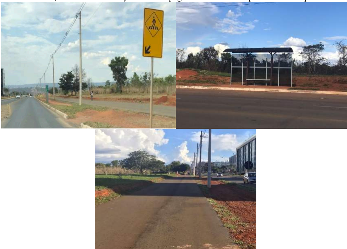
FIGURAS 25, 26 e 27 – Sinalização de vias apagada e ciclovia compartilhada com pedestres
