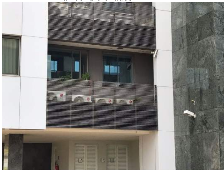
FIGURA 24 – Sacada de edifício tomada por aparelhos ar-condicionados
