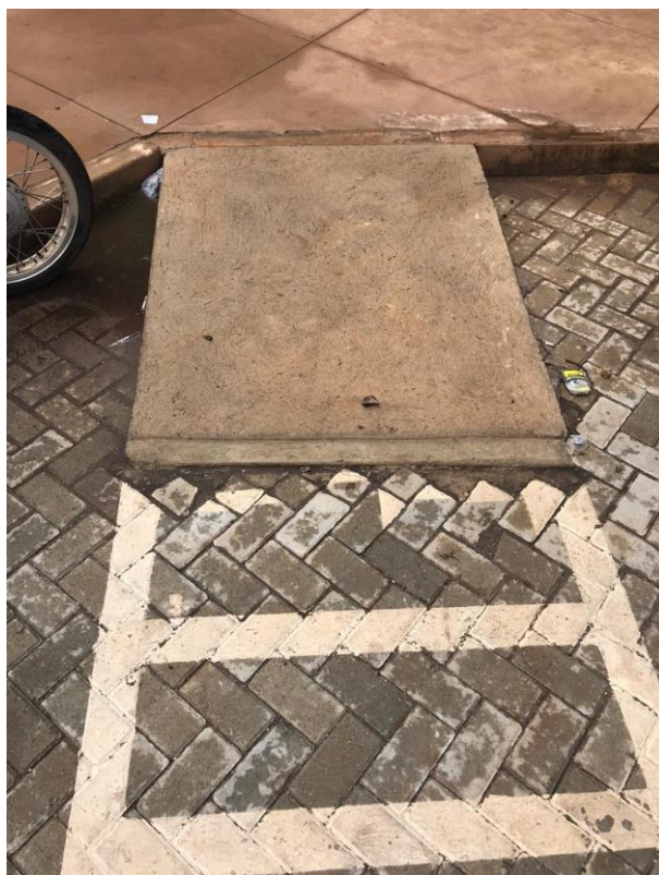
Figura 4.1 - Detalhe da rampa de concreto de acesso à calçada e pintura sobre revestimento de blocos intertravados
