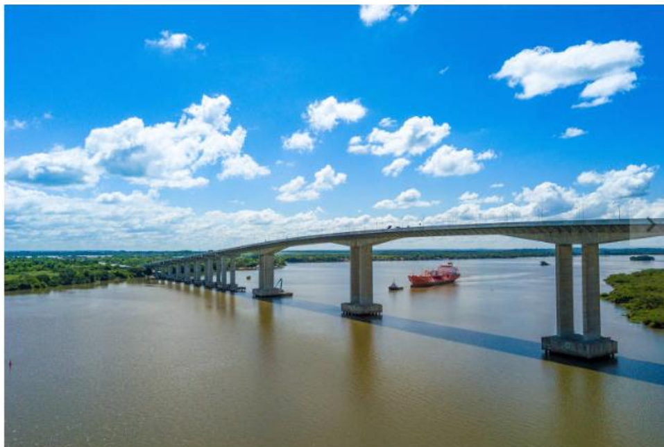
Figura 14 - Nova Ponte do Guaíba
