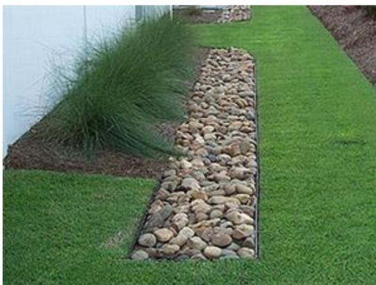
Figura 6. Trincheira de infiltração. Fonte: SuDS Wales, 2019.
