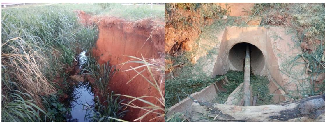
Figura 15. Voçoroca com vazão de esgoto em canal natural e bueiro com tubulação de esgoto na UnB.
