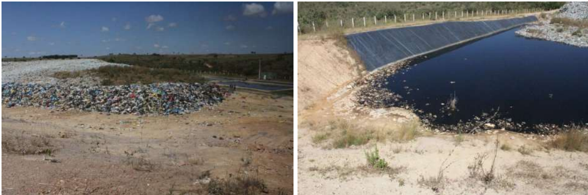
Figura 4.7 e 4.8 Células do Aterro sem cobertura diária e chorume fora das lagoas de percolação.
