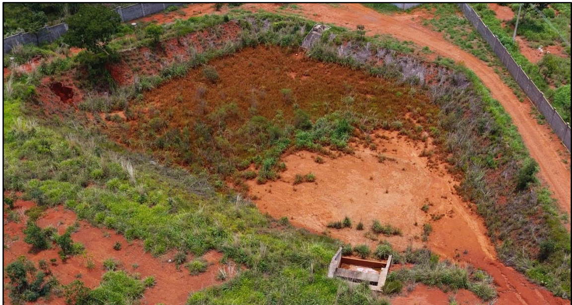
Figura 4.9 – Foto de drone do reservatório de quantidade
