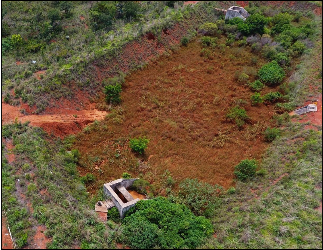
Figura 4.8 – Foto de drone do reservatório de qualidade
