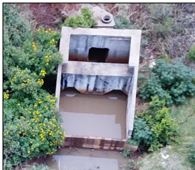
Figura 4.11 – Foto de drone de um dos dissipadores do reservatório de qualidade
