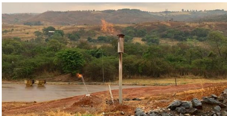
Figura 3.6 - Queimador em funcionamento do ASB
