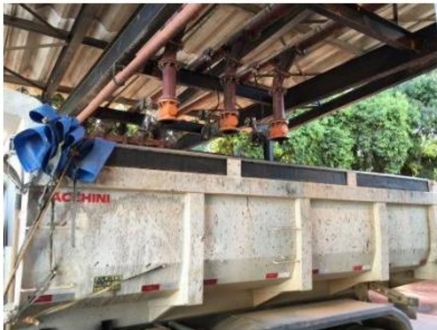
Figura 5-15: Caçamba de transporte de lodo na ETEB Sul (Governo Do Distrito Federal, 2017)
