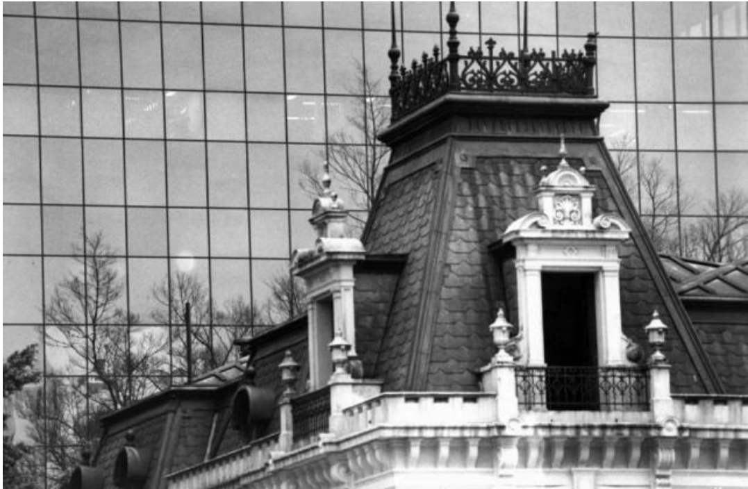
Figura 1 - Detalhe do telhado da Casa das Rosas com o Edifício Parque Paulista
