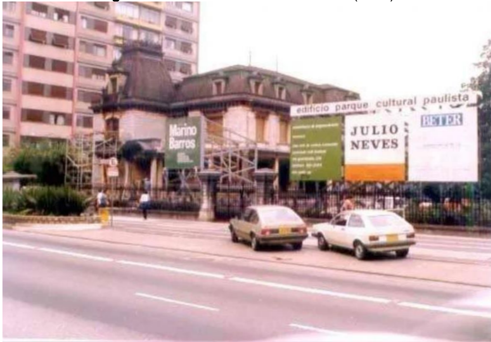
Figura 13 – Fachada durante as obras (1987)
