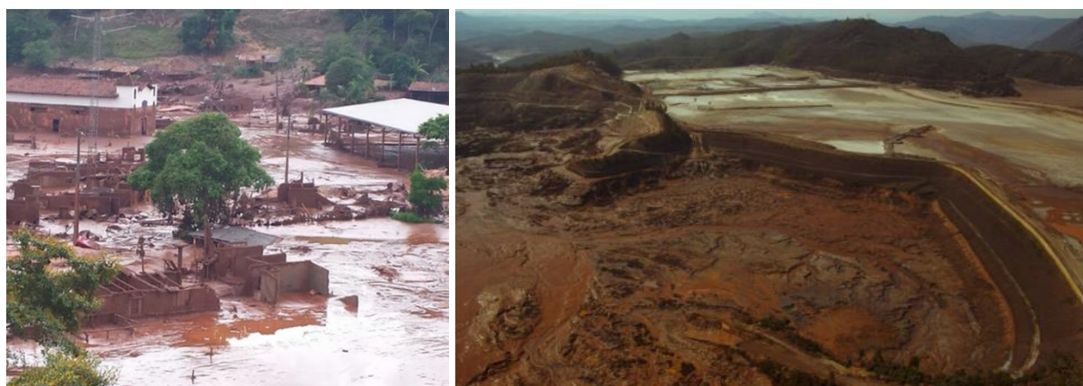
Figura 2.7 – Imagens da lama despejada após o rompimento da Barragem do Fundão (FREITAS, 2015; MARENCO, 2015).
