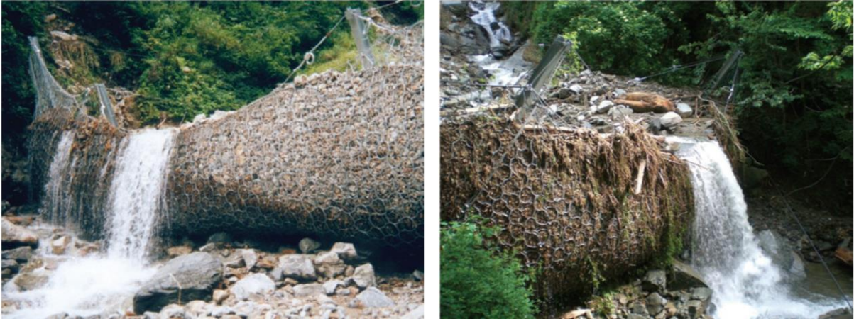
Figura 2.10 – Uso de barreiras flexíveis em casos de corridas de detritos (VOLKWEIN et al. , 2011).
