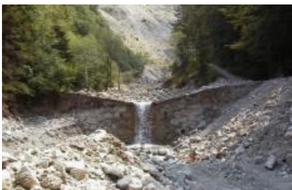
Figura 2.13 – Barreiras rígidas atuando de forma unitária ou em cascata (VANDINE, 1996; WAGNER, 2017)
