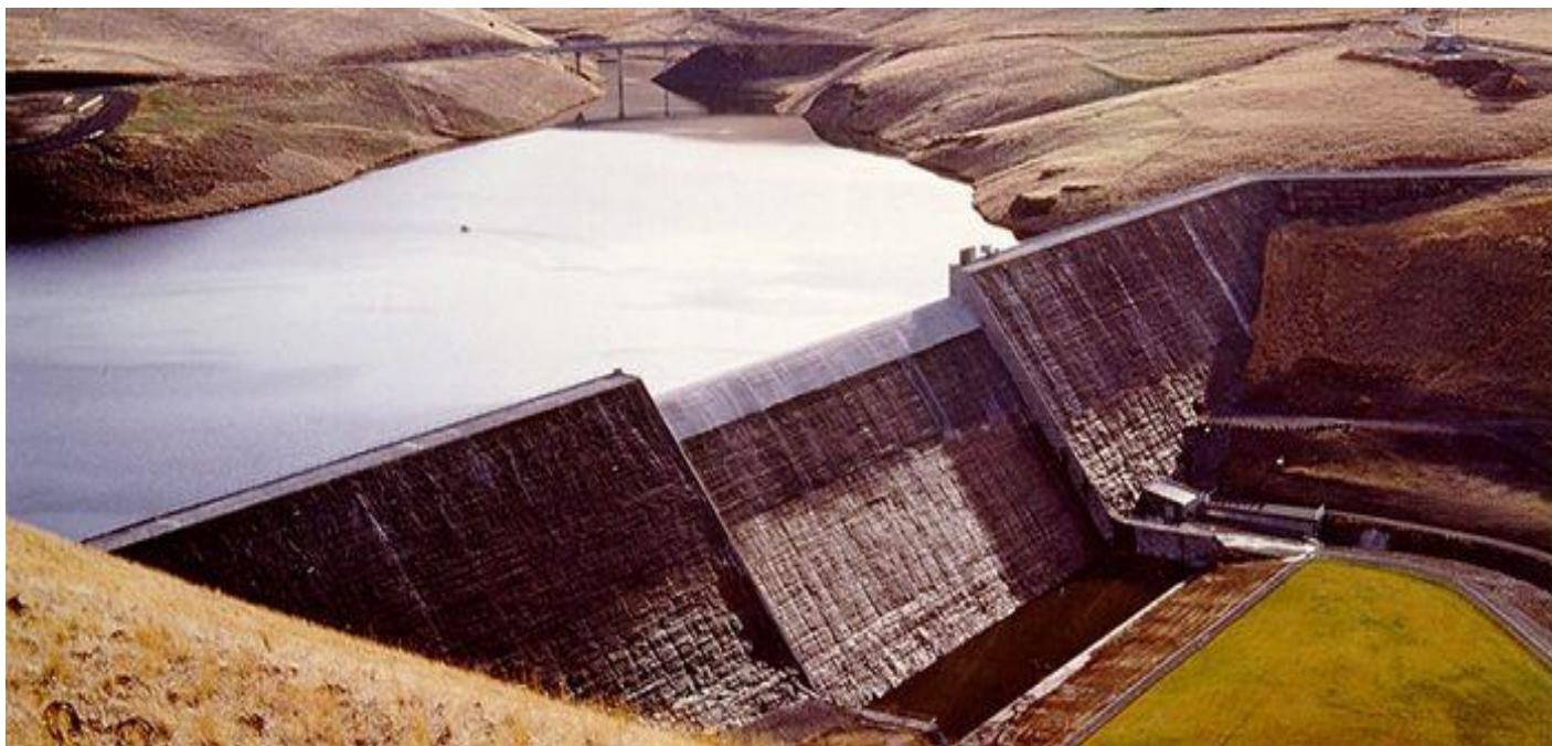
Figura 2 — Barragem de Gravidade de Concreto (EngWhere, 2018)
