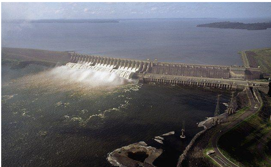
Figura 4 — Usina Hidrelétrica de Tucuruí. (ANA,2017)
