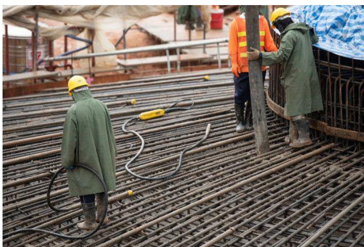
Figura 5— Trabalhador da construção civil concretando uma fundação
