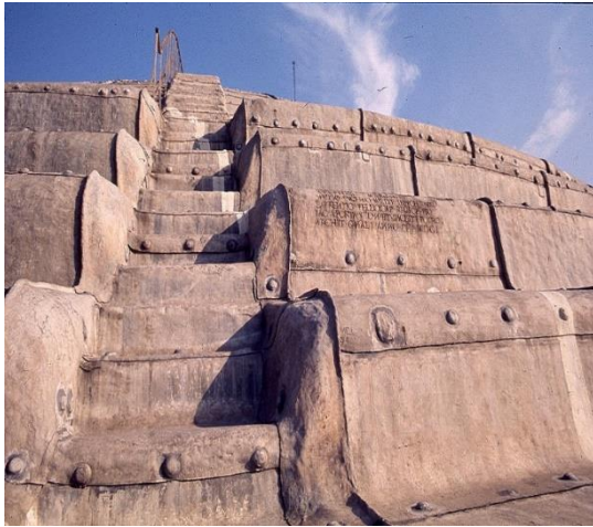
Figura 2.21 - Degraus de acesso da cúpula Fonte: Donovan, 1975
