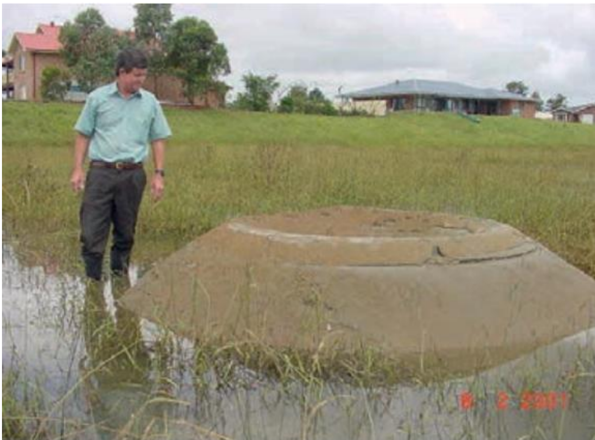
Figura 2-9: Cone de Areia à jusante de uma Barragem (ICOLD, 2017).
