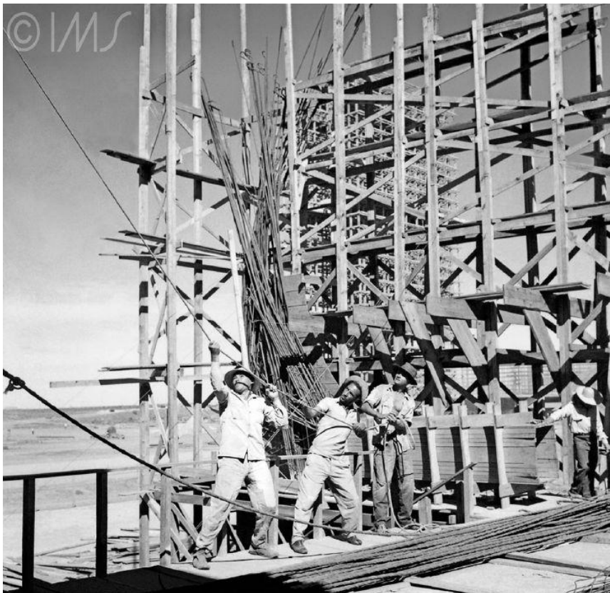
Imagem 9: Título: Congresso Nacional em construção. Autor: Marcel Gautherot. Ano: 1959. Acervo digital Instituto Moreira Salles.
