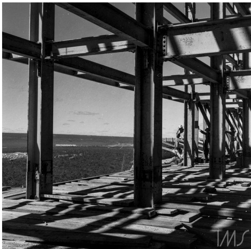
Imagem 10: Título: Congresso Nacional em construção. Autor: Marcel Gautherot. Ano: 1959. Acervo digital Instituto Moreira Salles.
