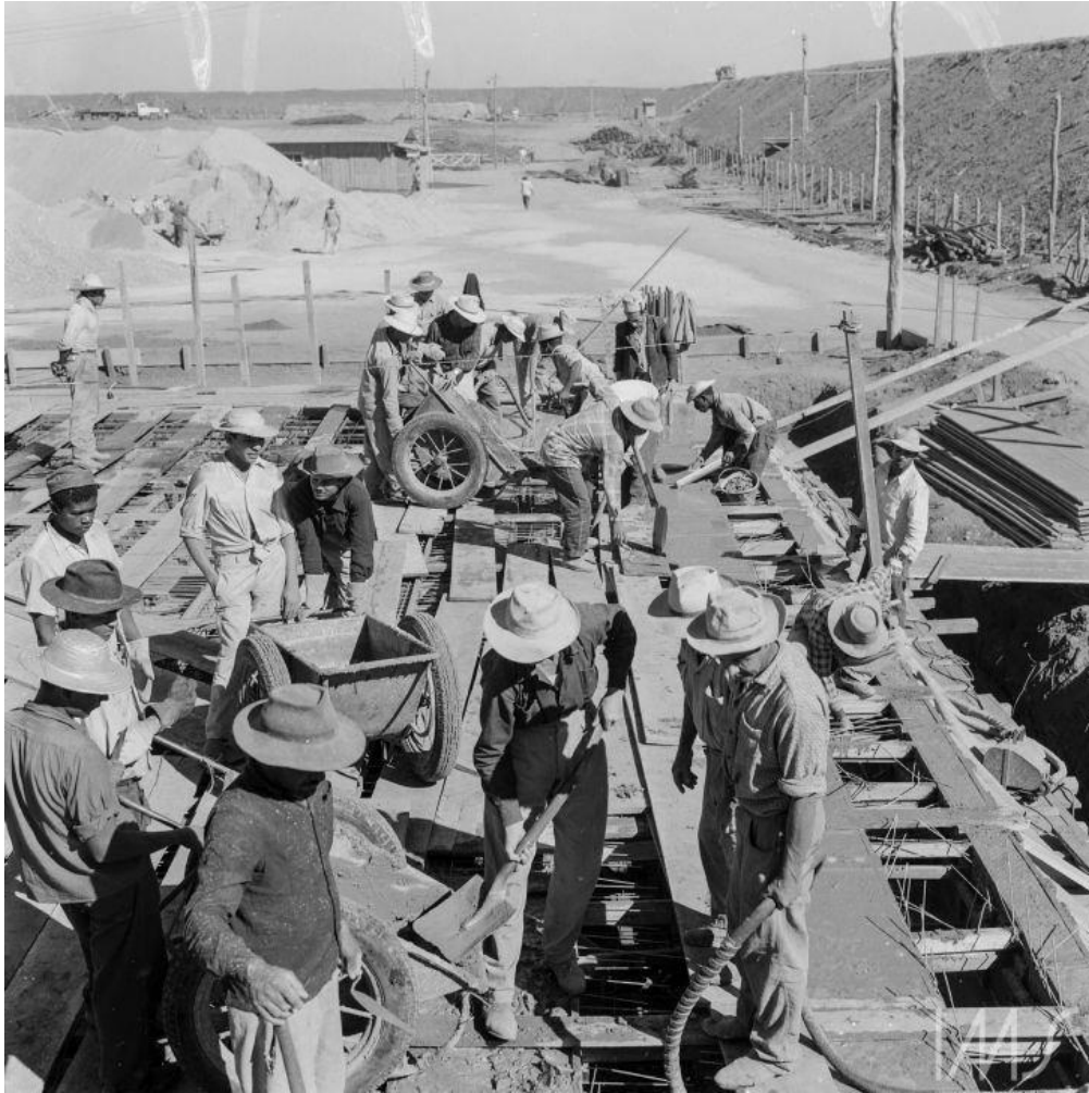
Imagem 5: Título: Trabalhadores na construção do Congresso Nacional. Autor: Marcel Gautherot. Ano: 1958. Acervo digital Instituto Moreira Salles.
