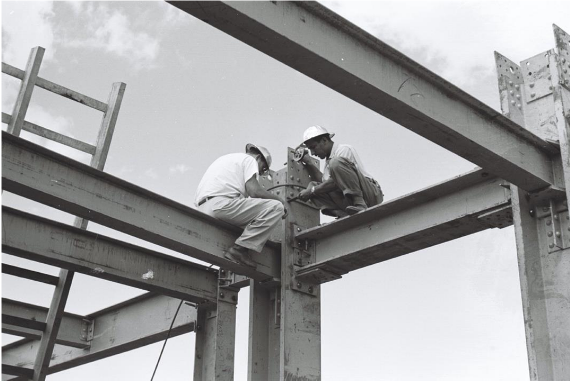
Imagem 3: Título: Dois operários rebitando uma viga na construção do Congresso Nacional. Autor: Mário Fontenelle. Ano: 1958. Acervo ArPDF. Fundo: Novacap.
