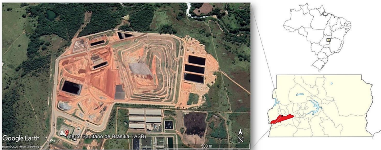
Figura 16. Localização do Aterro Sanitário de Brasília, com destaque para a região administrativa de Samambaia (em vermelho) 64 .
