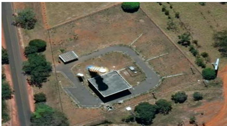
Figura 5 - Vista aérea da unidade.
