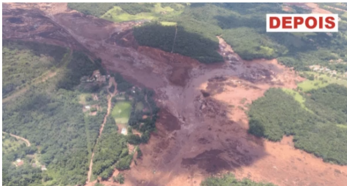
Figura 3 – Visão superior da região atingida pelo rompimento em Brumadinho (MG) Fonte: Google Earth
