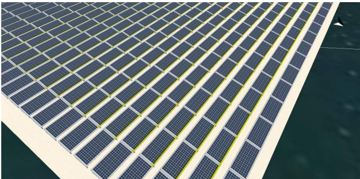
Figura 43 – Índice de sombreamento nos módulos fotovoltaicos.
