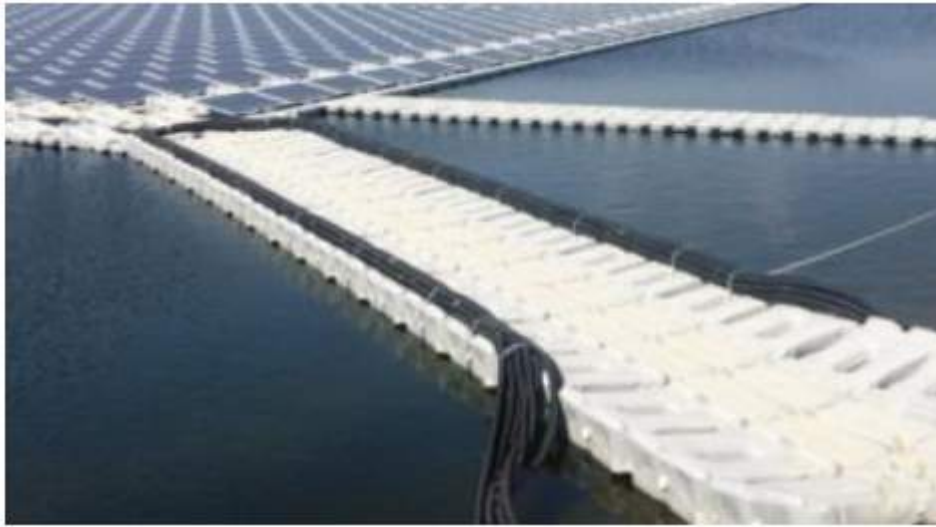
Figura 36 – Cabos instalados em uma plataforma flutuante.
