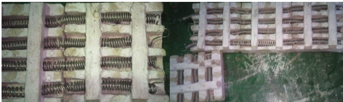
Figura 4.19 – Montagem da resistência elétrica no acoplamento do forno
