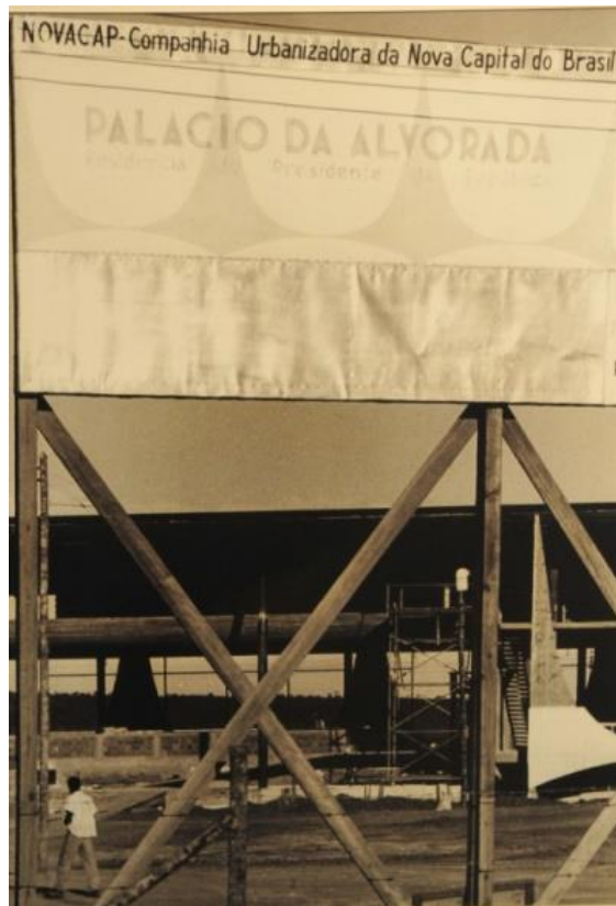
Figura 14 - Imagem de Placa Anúncio da Novacap e a construção do Palácio da Alvorada
