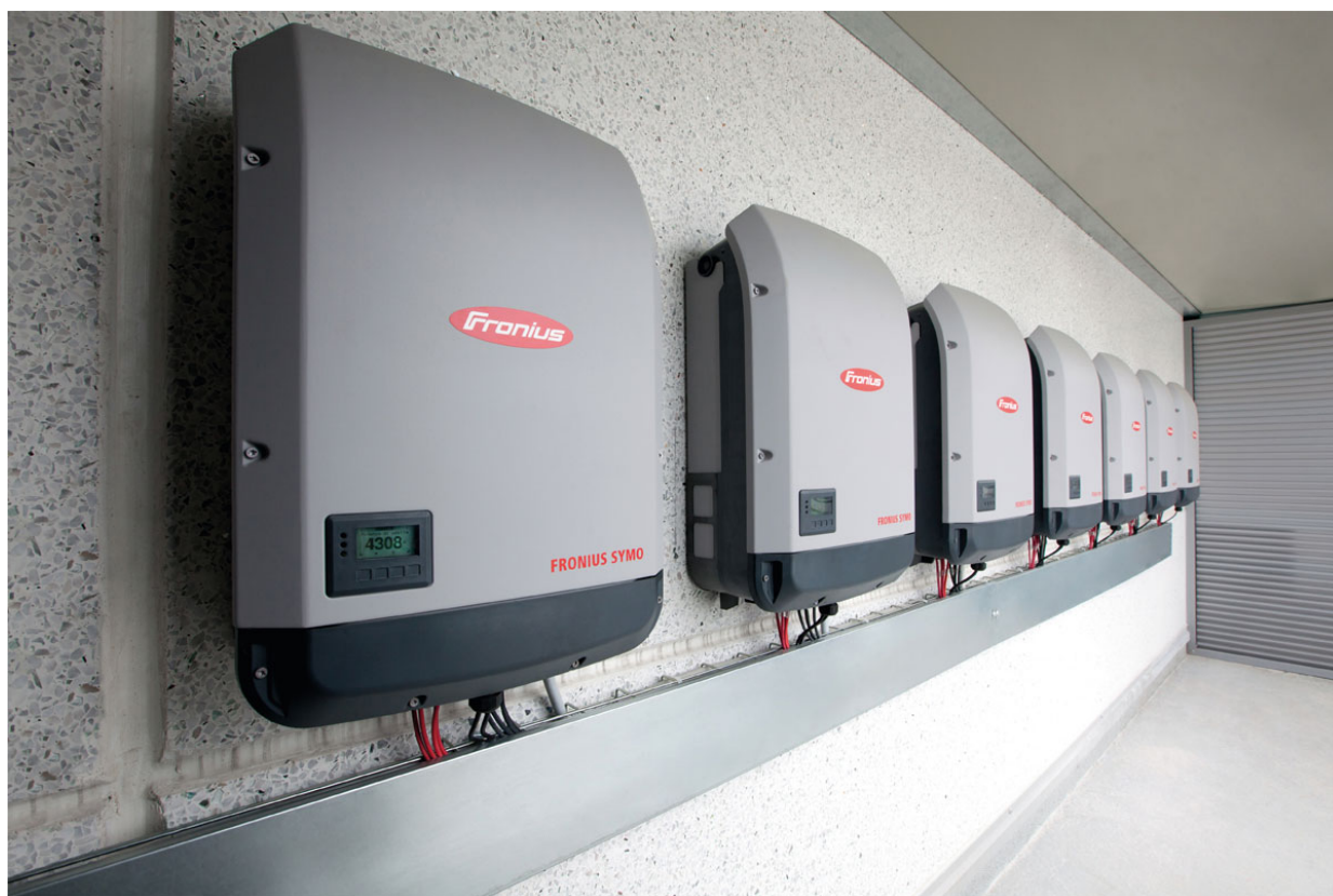
Figura 4.11: Exemplo de inversores solares Off-Grid (18).
