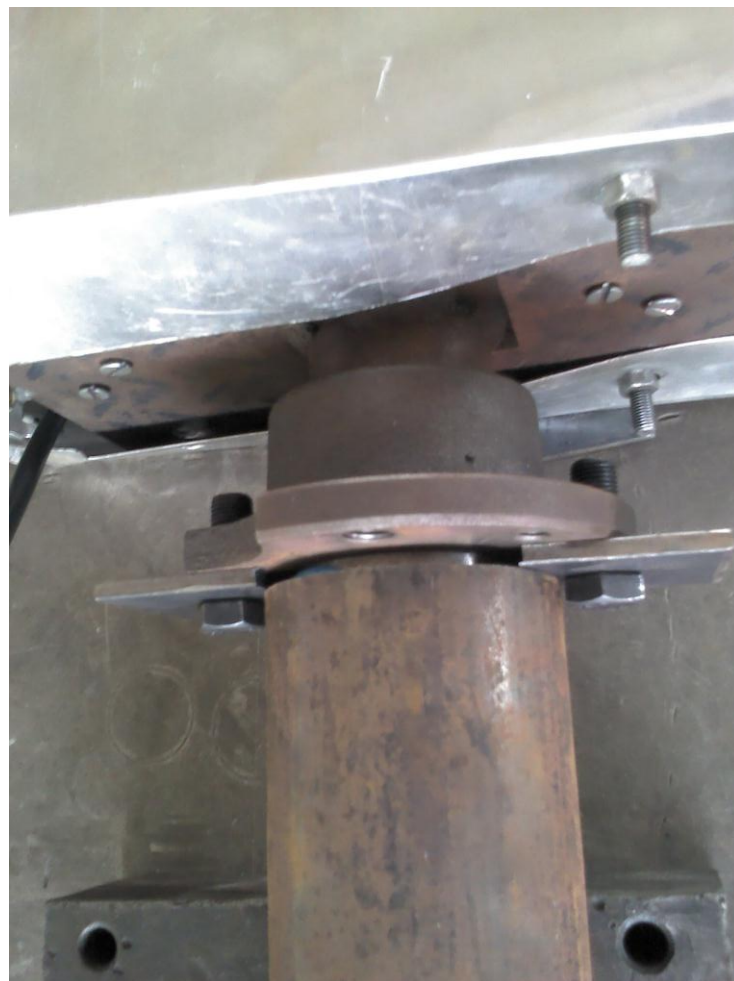
Figura 4.5 – Detalhe da fixação, orelhas antes de serem soldadas
