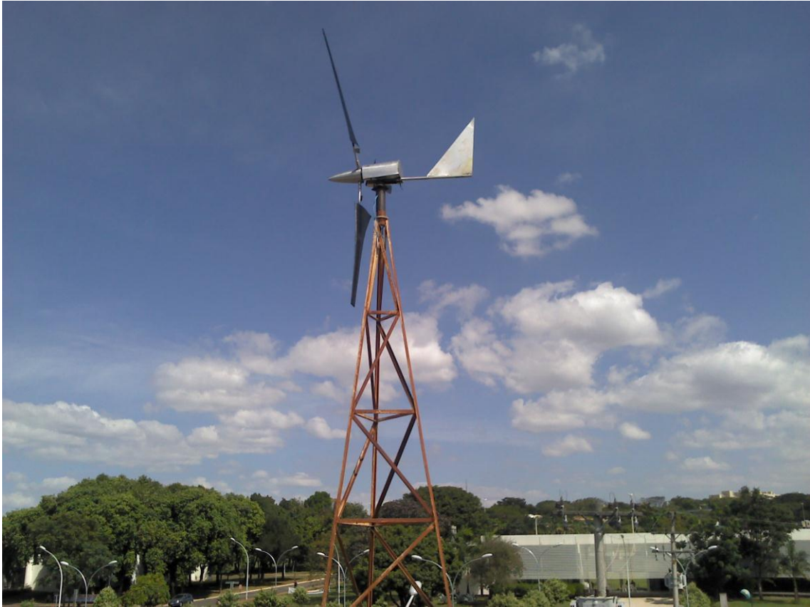
Figura 3.46 – Gerador eólico montado na torre com as pás
