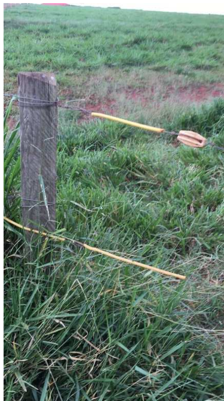
Figura 4.9 - Isoladores da cerca
