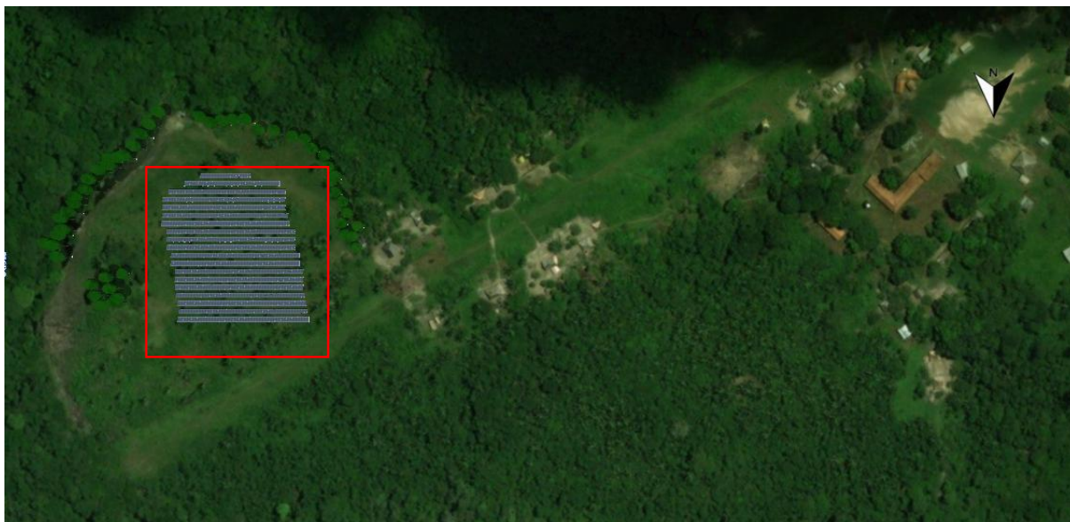
Figura 4.3: Alocação dos módulos fotovoltaicos na Aldeia Teko-Haw
