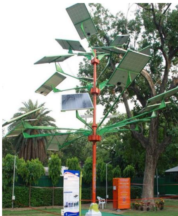
Figura 2.16 – Árvore solar do CSIRs instalada na Índia.
