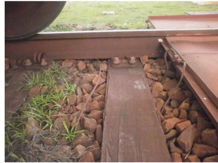
**Figura 7.13 – Interligação da malha**
