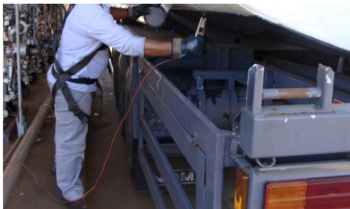
**Figura 7.4 – Aterramento do Autotanque**
