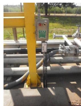
**Figura 7.11 – Sistema permissivo de aterramento**
