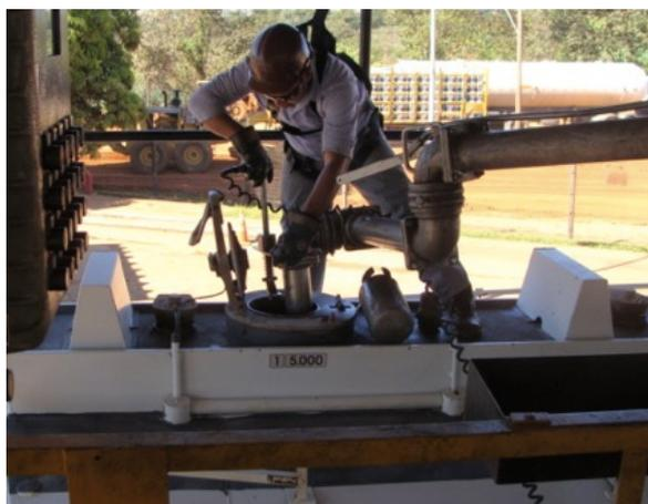
**Figura 7.6 – Carregamento do tipo “Top Loading”**
