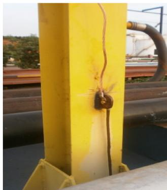
**Figura 7.7 – Aterramento da Plataforma**
