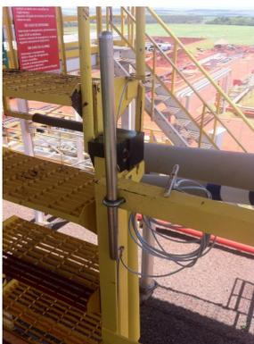
**Figura 7.9 – Bastão de Eliminação de Carga Estática**
