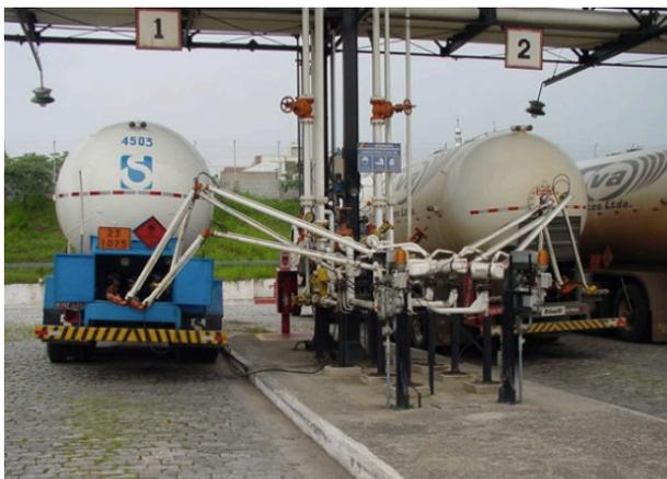
**Figura 7.5 – Carregamento do tipo “Bottom Loading”**
