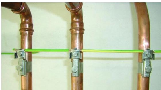
Figura 5.1 – Equipotencialização de tubulações metálicas
