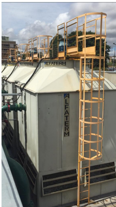
Figura 7 – Torre de resfriamento de tiragem mecânica. Fonte: O autor
