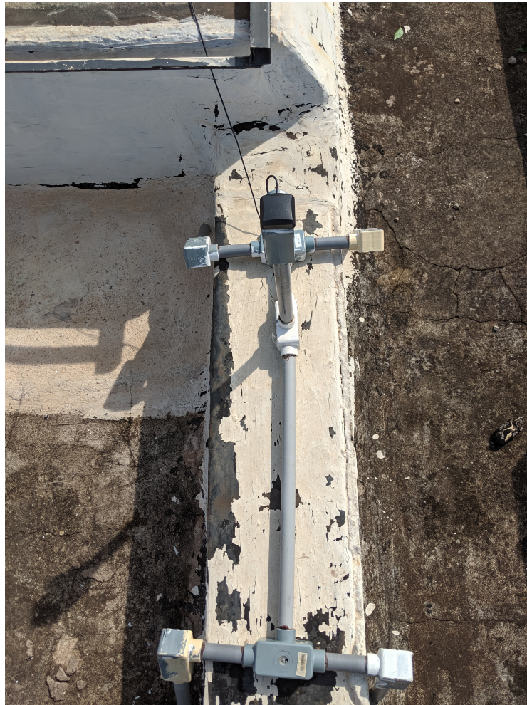
Figura 3.1: Instalação da estação base, com antena fixada por meio de estrutura de PVC
