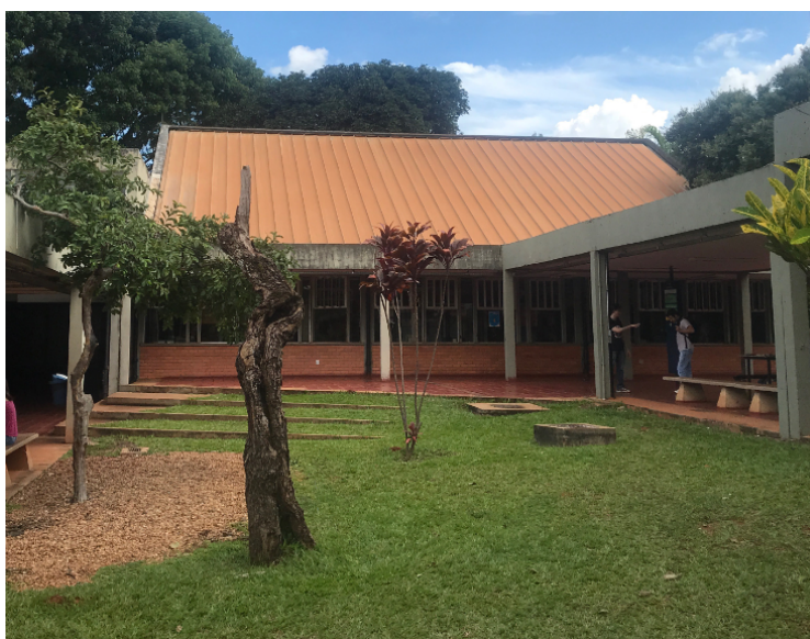
Figura 4.9: Área que possibilita a visualização dos módulos fotovoltaicos
