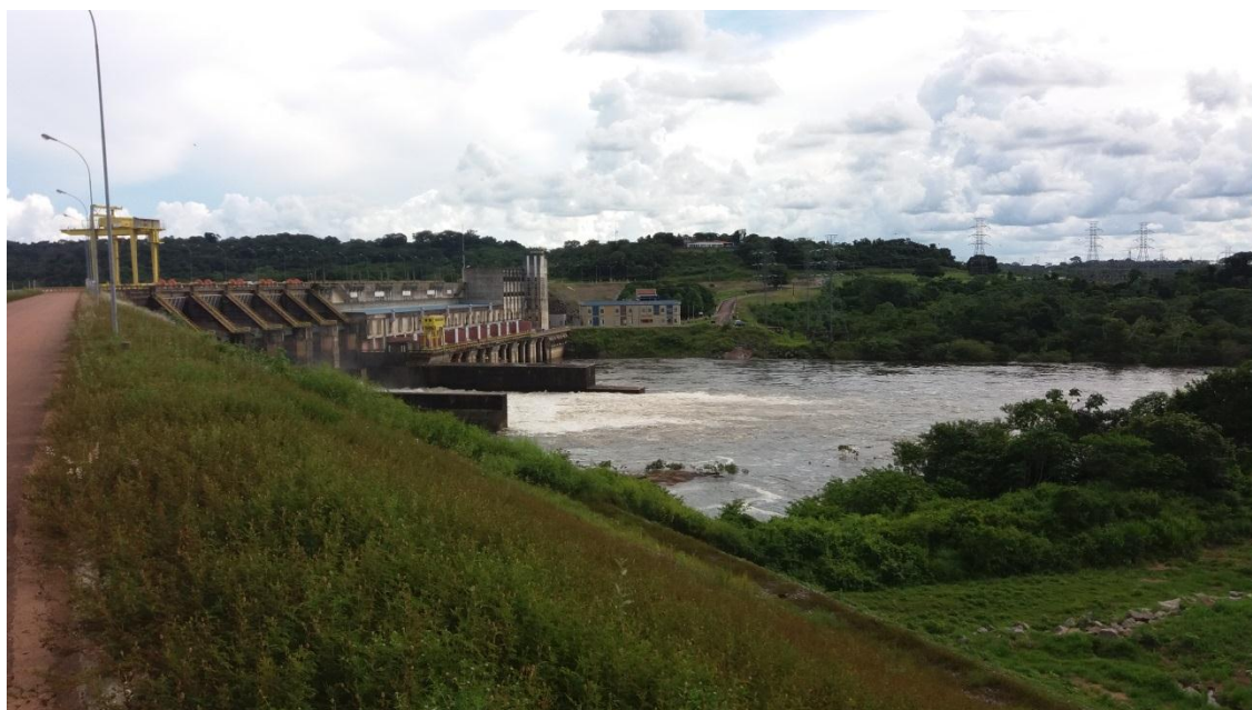
Figura 7.1 – Vista da usina hidrelétrica de Samuel.
