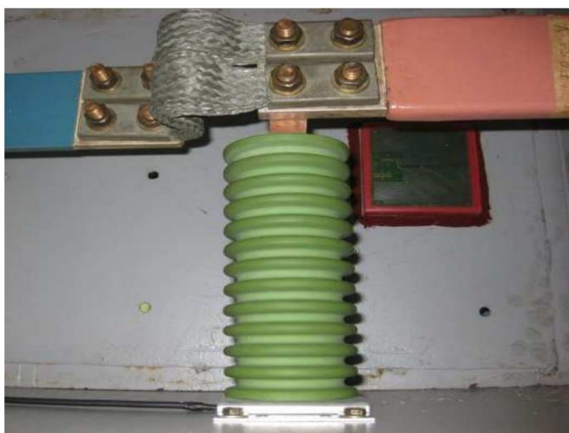
Figura 4.3 – Acoplador capacitivo de 80pF.
