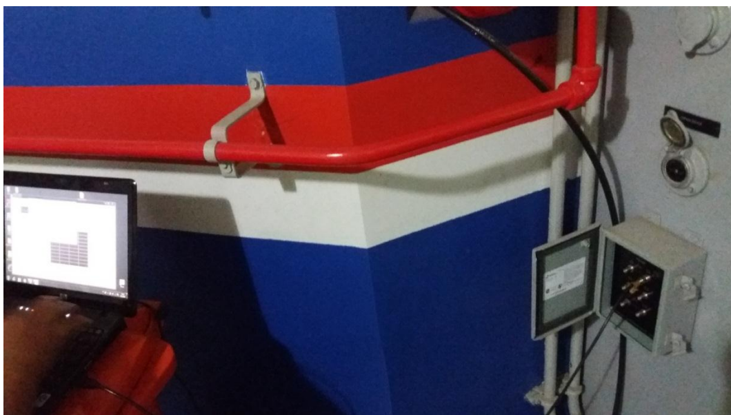
Figura 7.4 – Cabo coaxial instalado na caixa terminal.
