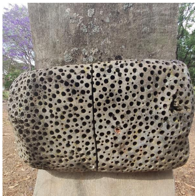
Figura 41 - Detalhe central obra sem identificação
