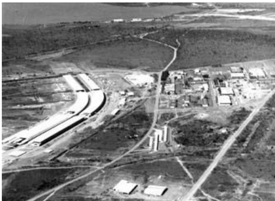
Figura 4 - Vista aérea do Campus Universitário em construção
