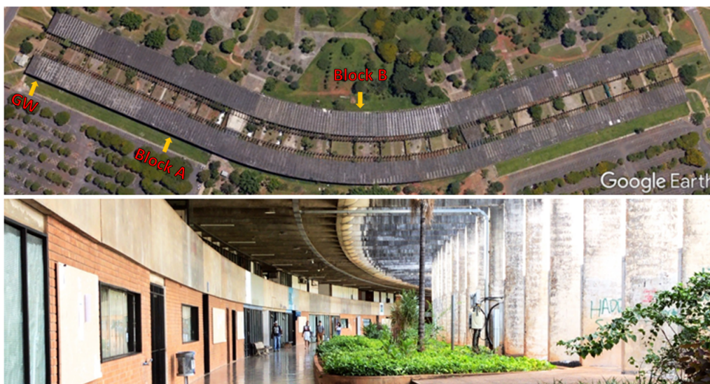
Figura 3.11: Imagens do Instituto Central de Ciências (Fonte: Google Earth e Elaboração Própria)
