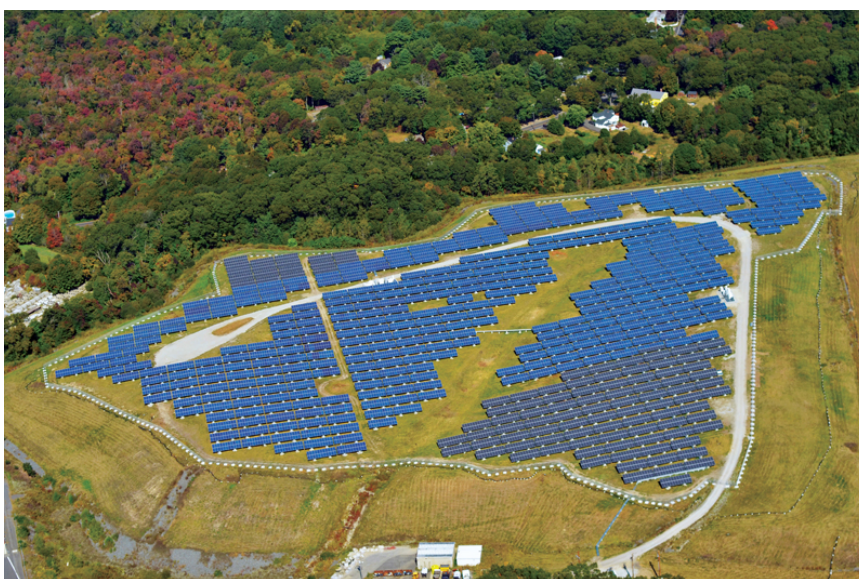
Figura 2.4: Usina fotovoltaica em Scituate [12].
