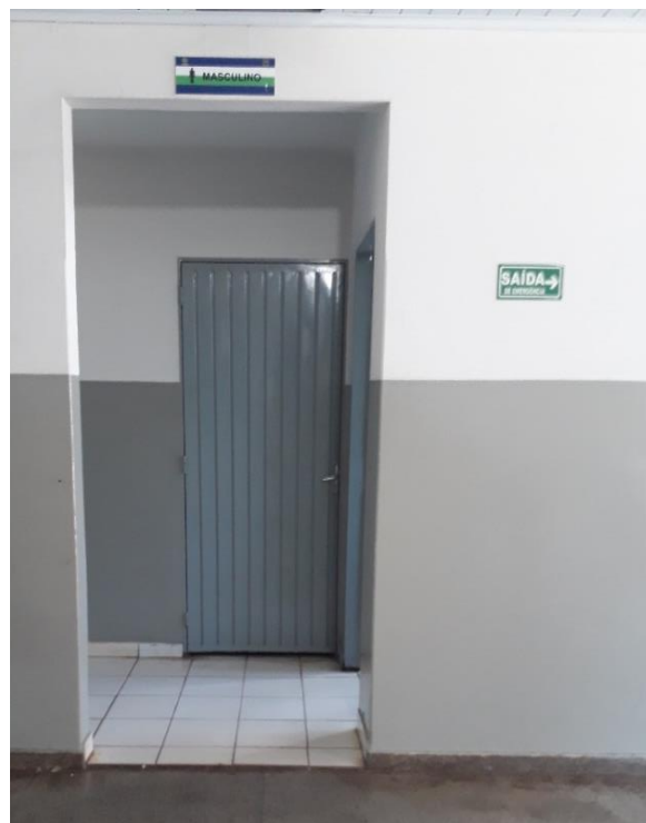
Figura 8–Banheiro acessível visão exterior
