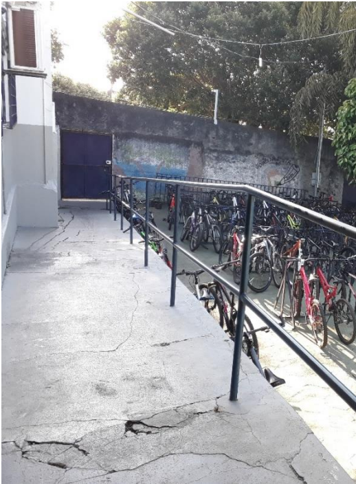
Figura 3 - Entrada lateral 2 - rampa
