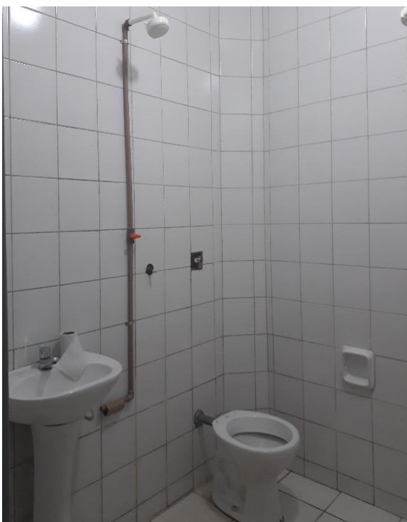
Figura 7- Banheiro acessível visão interior
