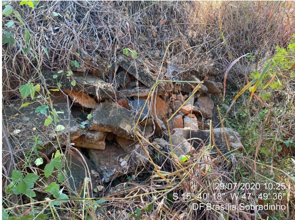
Foto 10. Entulho jogado dentro da Voçoroca.
