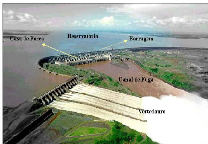
Figura 2.1 – Estruturas das Usinas Hidrelétricas
