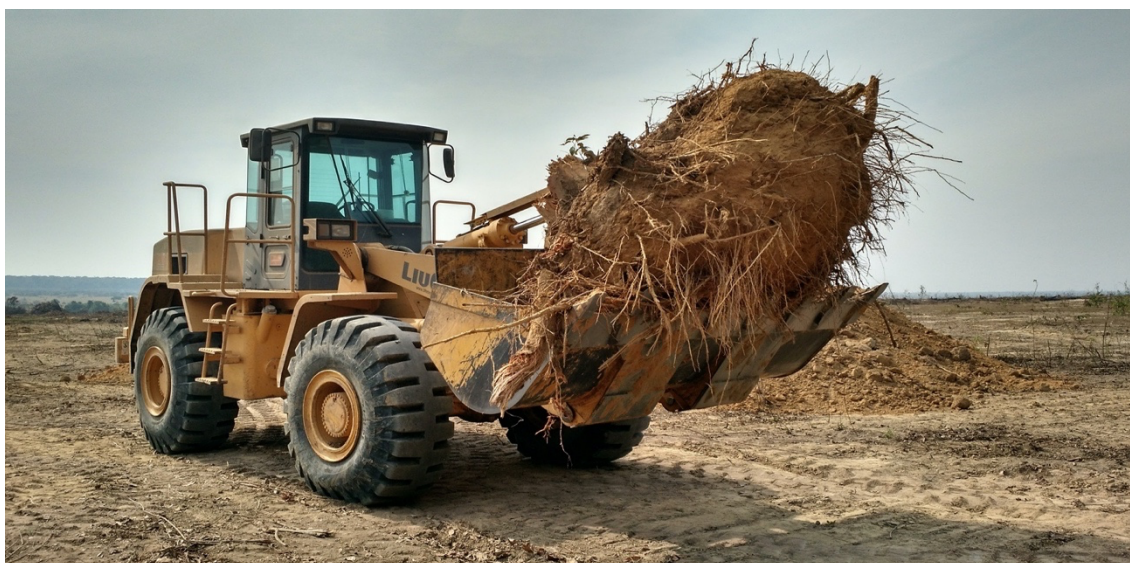
Figura 1. Retirada de tocos remanescentes da área da Faz. Maringá.
