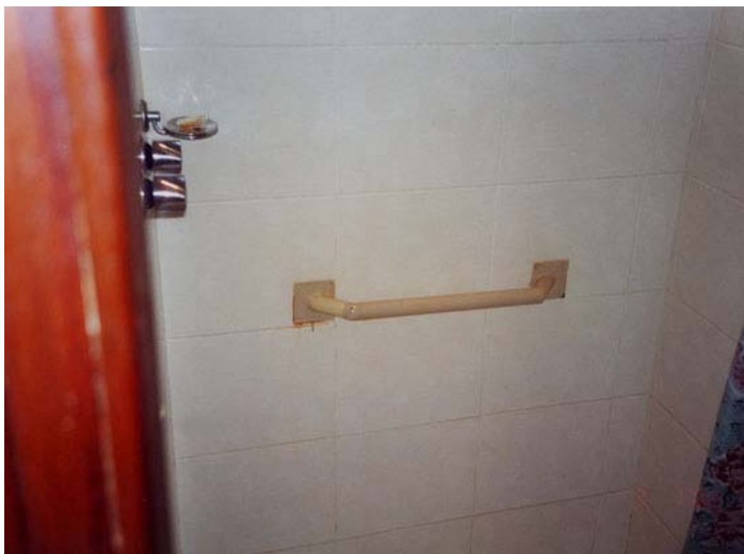
Fotografia n° 11: Interior do banheiro (detalhe do box com barra de segurança)
