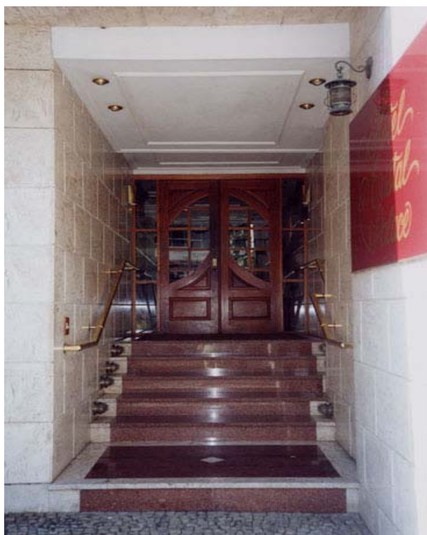
Fotografia nº 2: Entrada principal do Hotel
