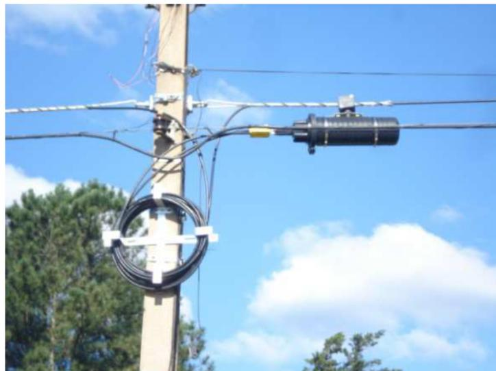
Figura 2.6: Exemplo de poste com uma caixa de emenda e reserva técnica instaladas (Fonte: [18]).
