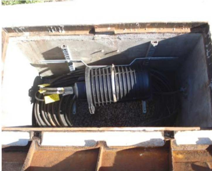
Figura 2.5: Exemplo de caixa subterrânea com uma caixa de emenda instalada (Fonte: [18]).
