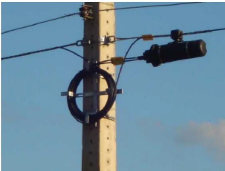
Figura 2.5: Exemplo de uma Caixa de Emenda Aérea com Reserva Técnica (Fonte: [21]).
