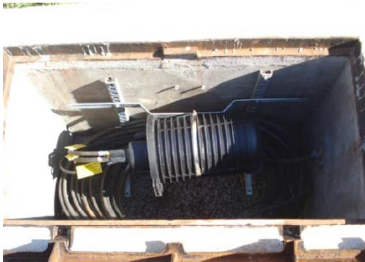
Figura 2.4: Exemplo de uma Caixa de Emenda Subterrânea (Fonte: [21]).
