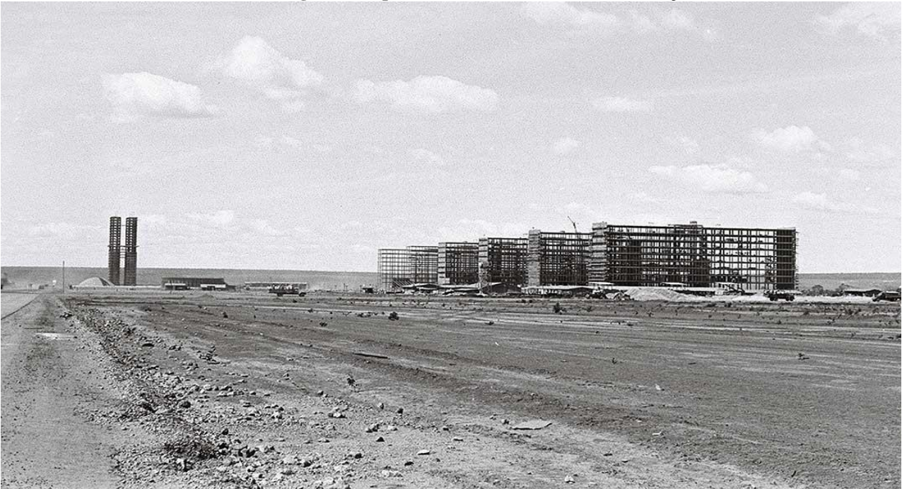
Figura 3: Esplanada dos Ministérios em construção
