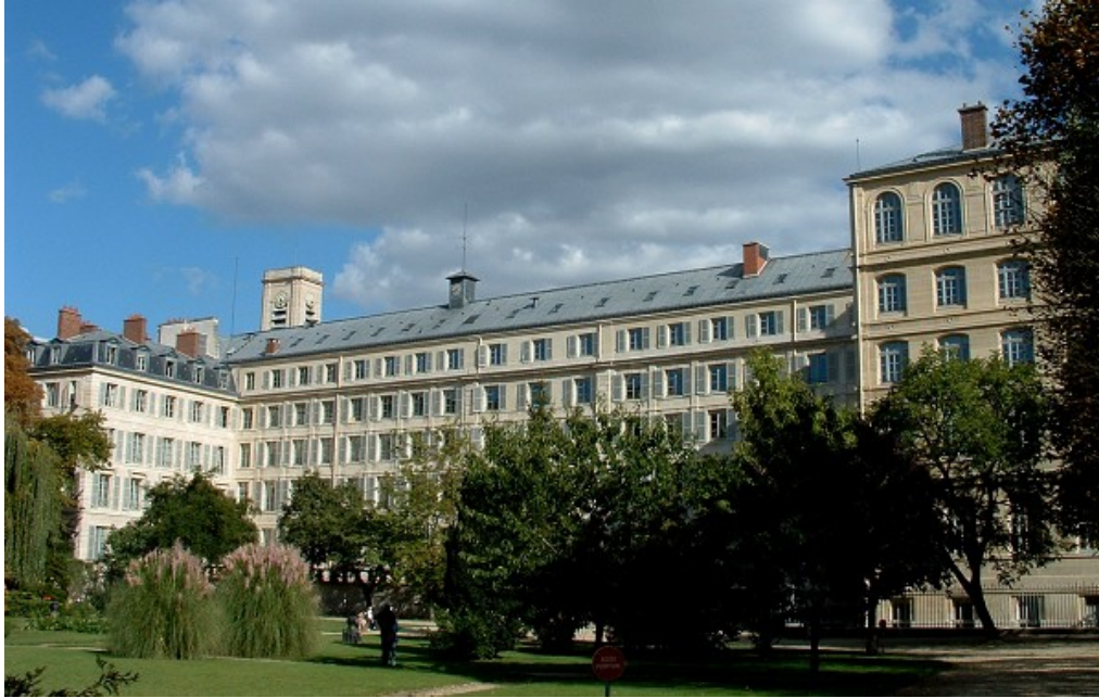
Figura 8 – Vista do pátio interno e das instalações do Instituto Nacional dos Jovens Surdos de Paris.
