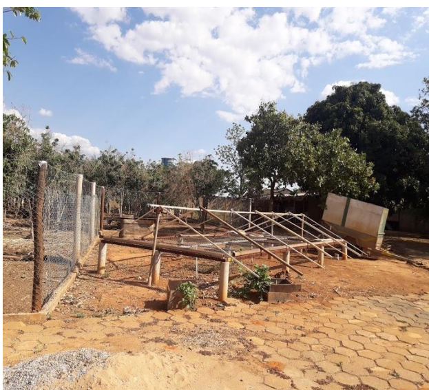
Figura 2- Terreiro Suspenso de Alvenaria.
