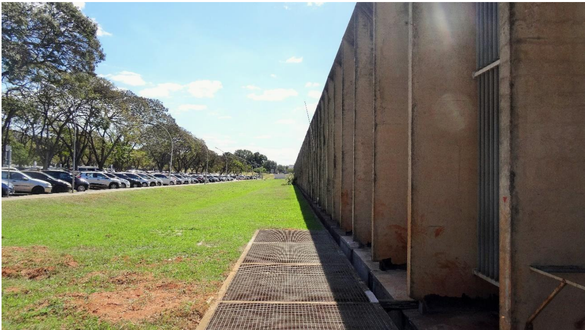
Instituto Central de Ciências Norte – ICC norte
