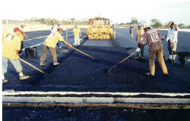
Figura 2- Demonstração do revestimento asfáltico em via pública
