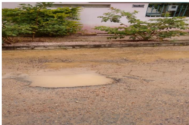
Figura 10- Buraco tapado com bloquetes sextavados de calçamento
