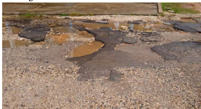
Figura 6- Rua com asfalto removido
