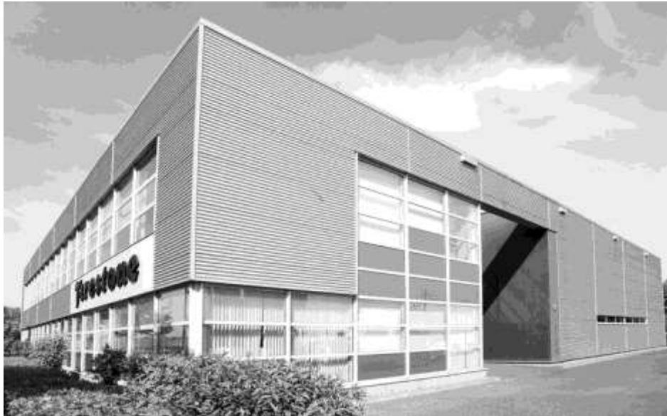
Figura 4. Instalações da Firestone Industrial Products na cidade de Arnhem, na Holanda. Fonte: Green Real State.
