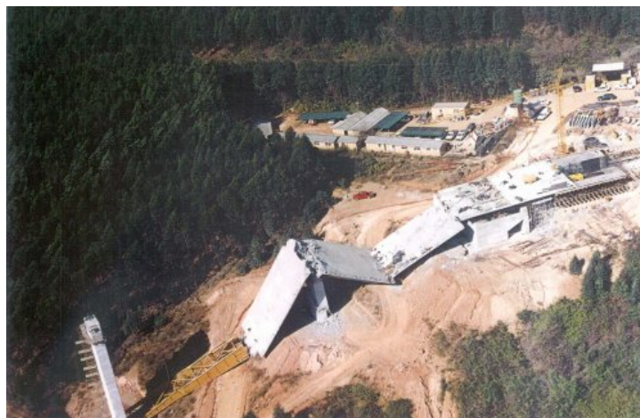
Figura 2 – Colapso da Ponte Injaka, ocorrido em 06 de julho de 1988.
